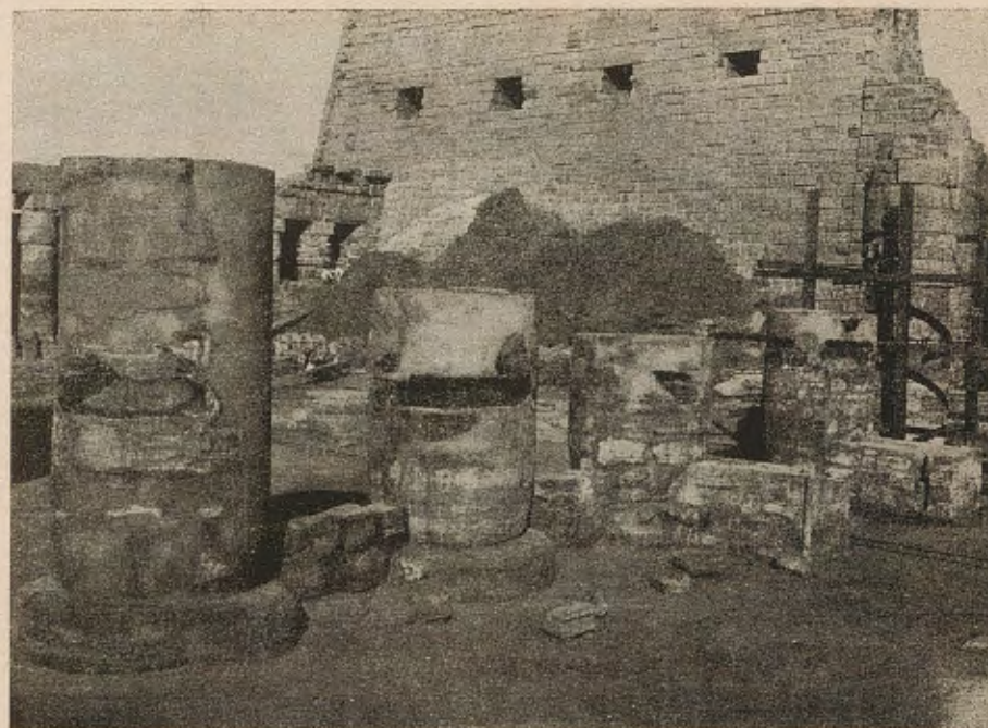
a. — Colonnes de Taharqa, après consolidation (rangée sud).
